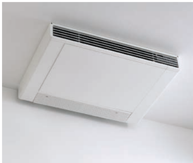
Фанкойл закреплен на потолке
