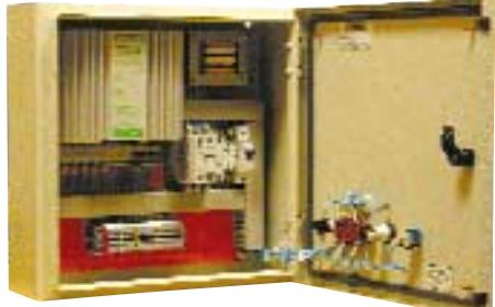
**Серия управляющих модулей АСМ/Е для приточных систем с электрическим нагревателем.**
