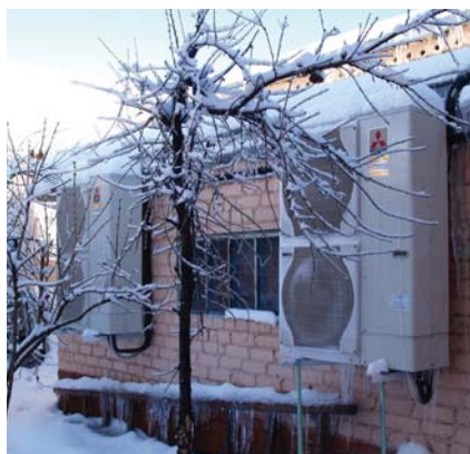
Отопление тепловыми насосами ZUBADAN Inverter
